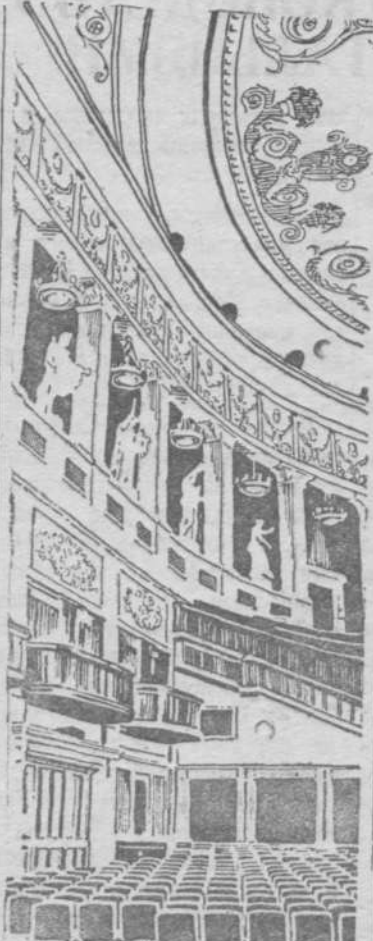
На строительстве Новосибирского оперного театра. На снимке: часть зрительного зала. С фото А. Сокомахина.
