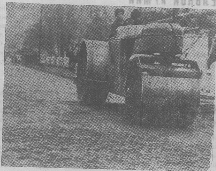
Строительство дороги на Комсомольской улице. Фото А. Смокунович.
