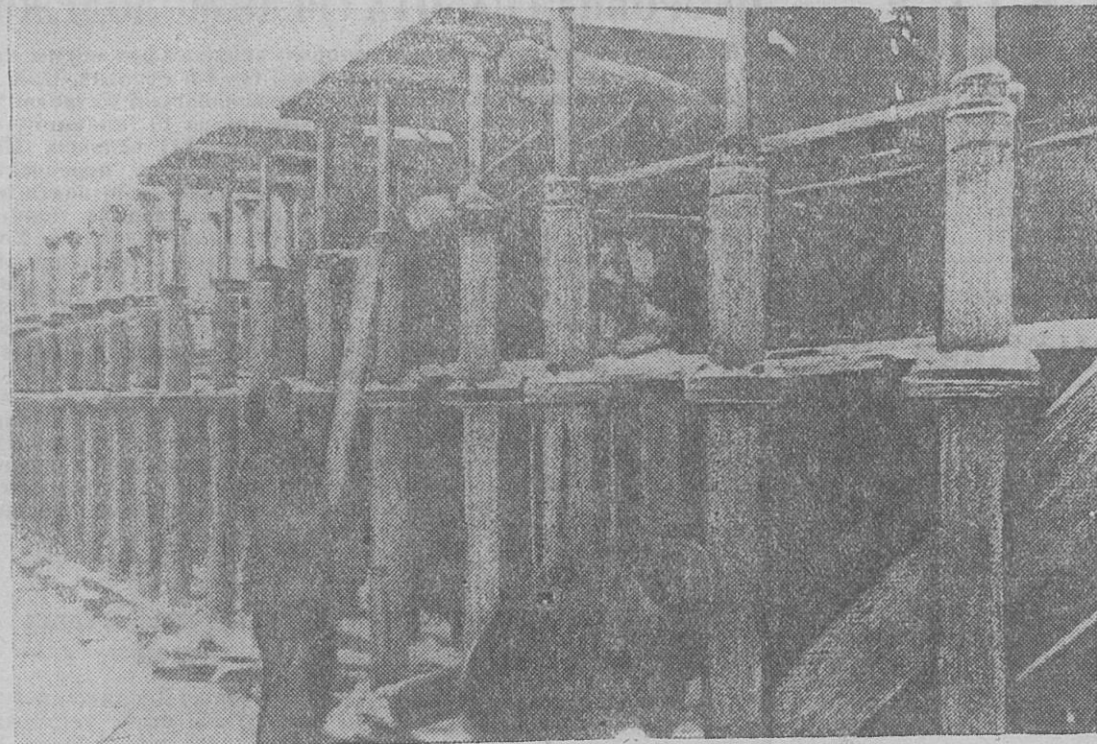
На шахте им. Сталина заканчивается монтаж металлического крепления. НА СНИМКЕ: Монтаж металлического крепления.
