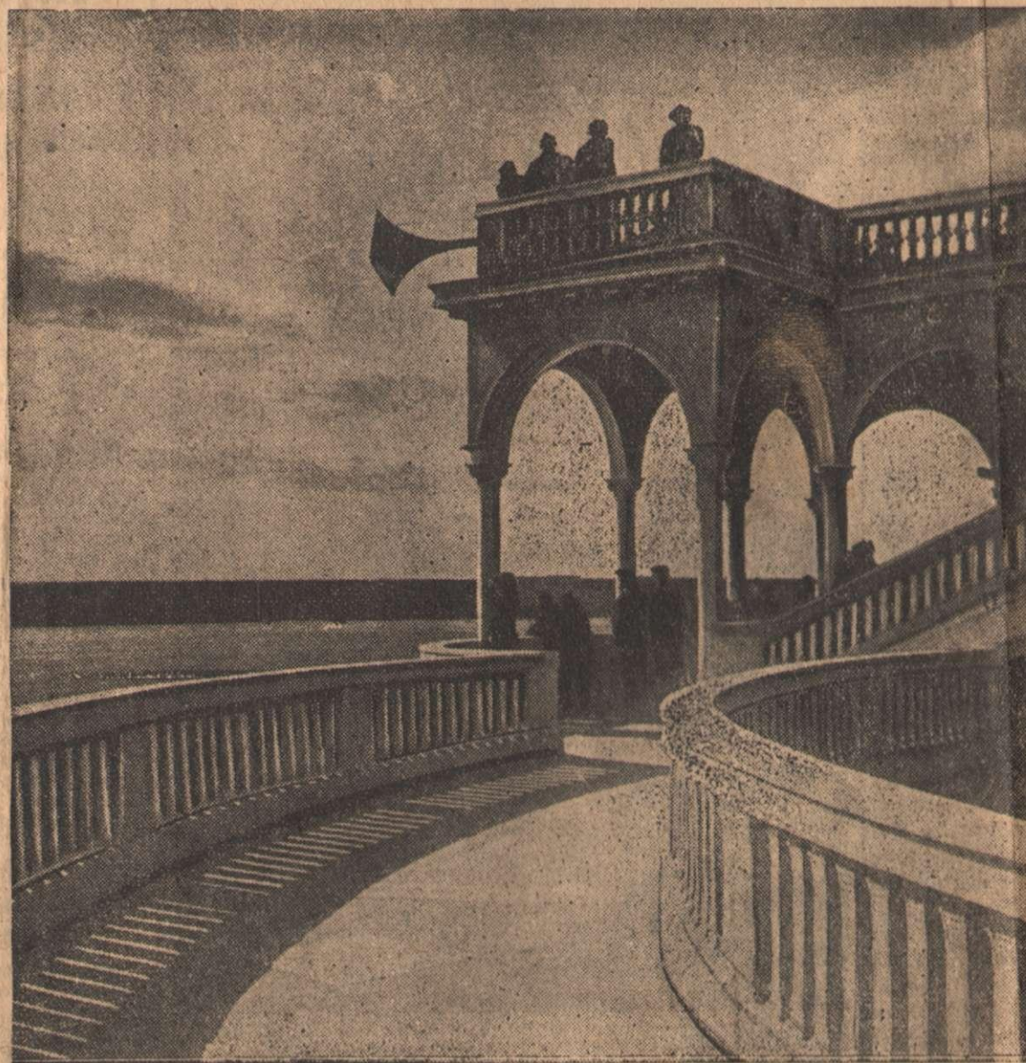
На снимке речной вокзал в Химках (балкон 1-го этажа).
