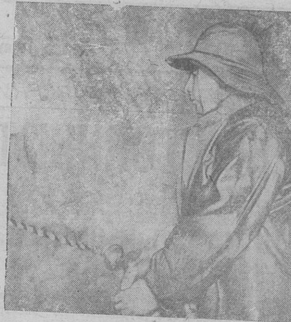
НА ШАХТЕ № 6. Работа электросверлом
