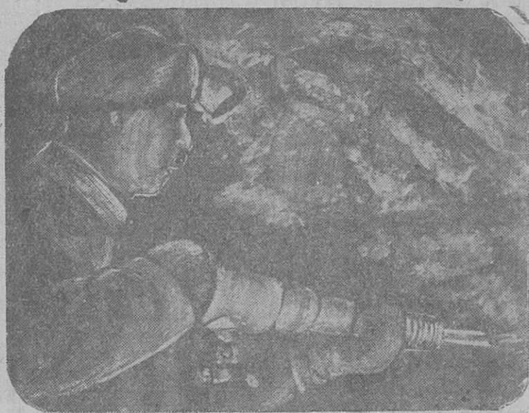
Работа отбойным молотком (Центр. штольня).
