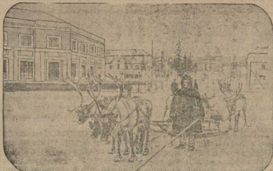
К предстоящему торжественному пуску самой северной полярной гидростанции на реке Тулеме. В три года в тяжелых климатических и геологических условиях осуществлена грандиозная стройка Туломской ГЭС. В обитаемой местности выстроен образцовый городок. Первая турбина мощностью 13 тысяч киловатт (советского производства) уже дает ток Мурманску. На снимке: улица рабочего городка на Туломской ГЭС. (Союзфот)
