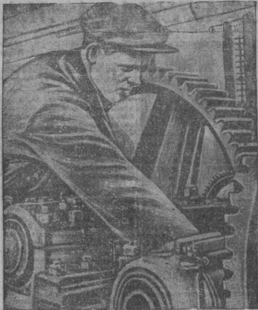
Ленинградский завод подъемных сооружений им. Кирова приготовил две лебедки для подъема щитов плотины Канакарской гидроэлектростанции. Грузоподъемность каждой лебедки—30 тонн. На снимке: сборщик Д. Р. Коробко проверяет лебедки. (Союзфото)
