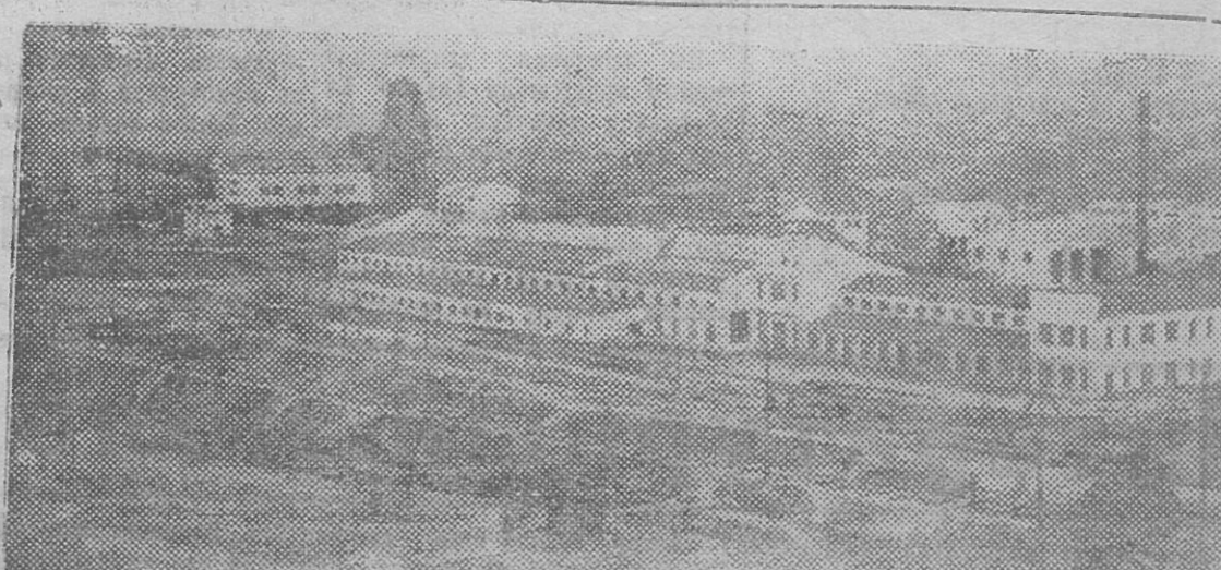
Шахта им. Сталина (Консовая 1). Крупнейшая механизированная фабрика угля в Юго-Западной Сибири. Производительность шахты свыше 100 тысяч тонн угля в год.
