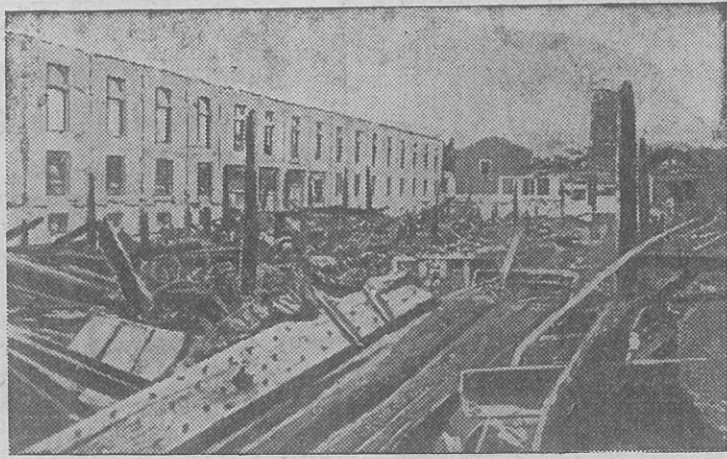
Война в Западной Европе. На снимке: Разрушения на заводе Ситроен (Франция).
