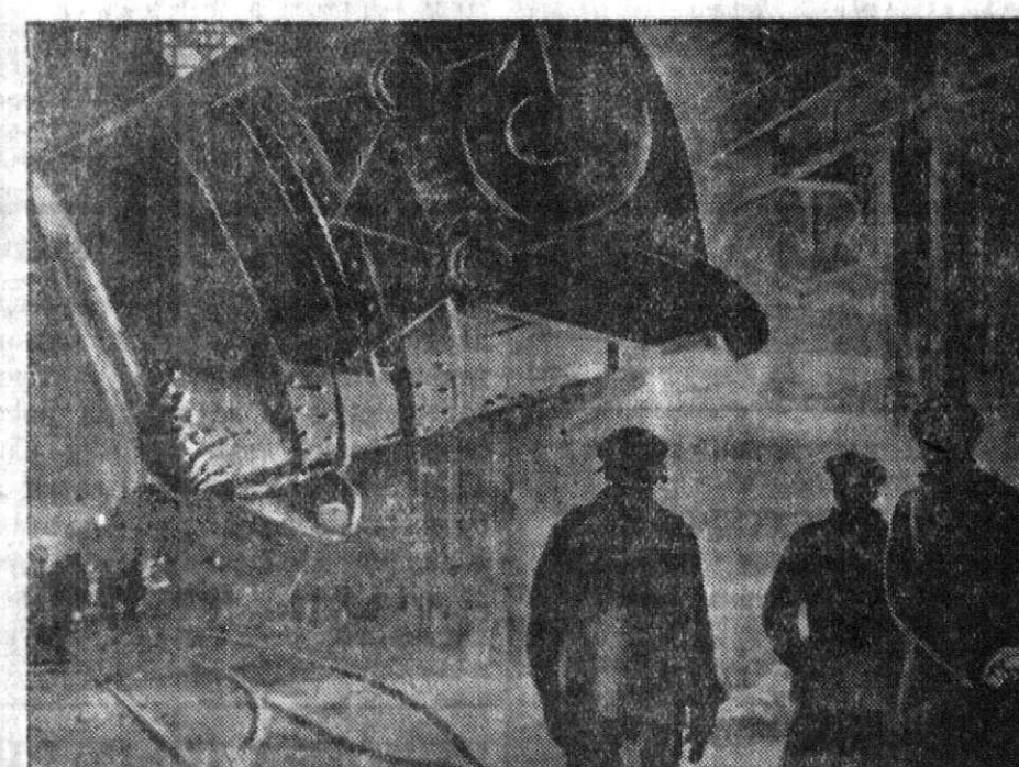
На Кузнецком металлургическом заводе им. Сталина. На снимке: заливка чугуна в мартеновскую печь.
