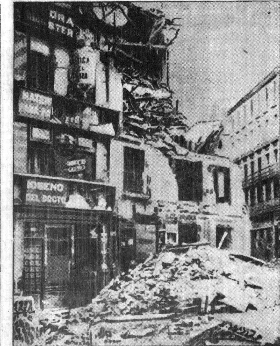
Разрушенные неприступностью Мадрида интервенты и митетники превращают его в развалины при помощи дальнобойной артиллерии. На снимке: разрушенный фашистскими бомбами дом на площади Мартина в Мадриде. СООЗФОТО.
