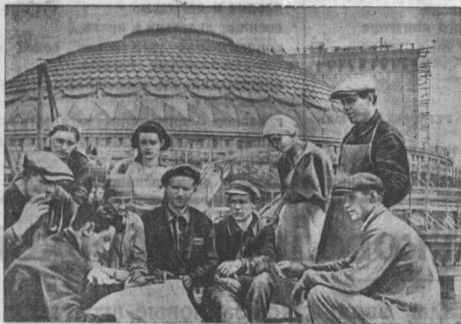
На строительстве Новосибирского большого оперного театра. На снимке: бригадир станочников Д. А. Мельников ежедневно читает в своей бригаде газеты. Фото В. Маршала.
