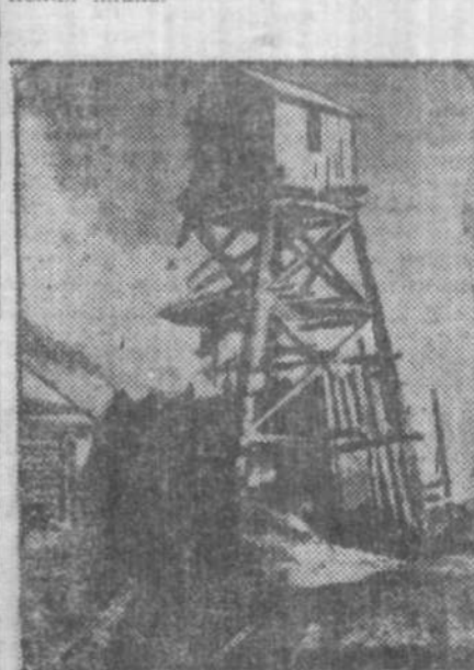
В марте вступает в строй новая шахта № 16 в Анжеро-Судженке. На снимке: временный копер шахты.
