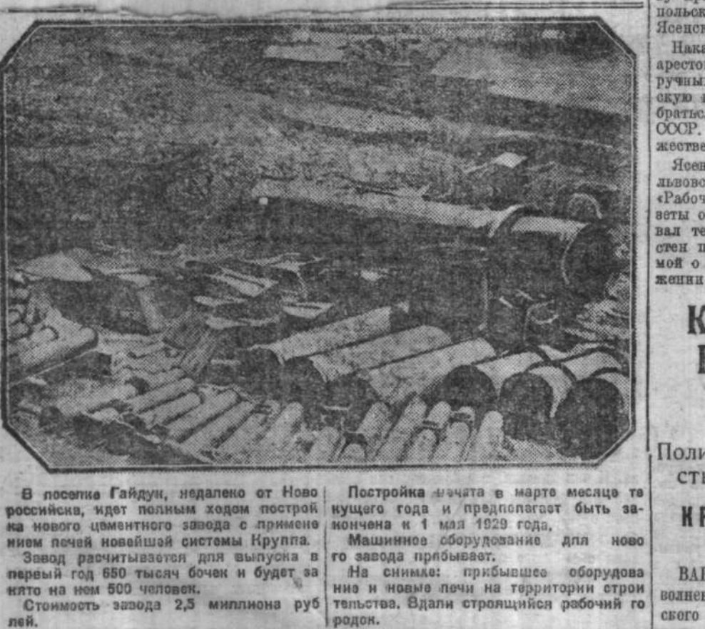
В поселке Гайдун, удаленном от Ново- сибирска, идет полным ходом построй- ка нового цементного завода с приме- нием новейших систем Круппа. Завод рассчитывается для выпуска в первый год 650 тысяч бочек и будет за- нять на нем 500 человек. Стоимость завода 2,5 миллиона руб- лей.
