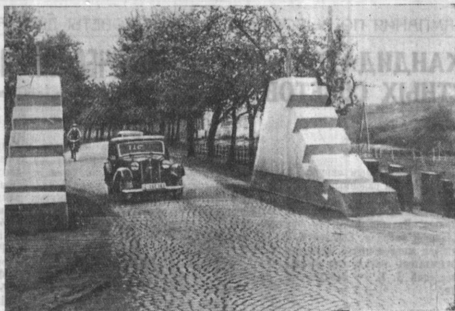
Германские укрепления на западной границе. На снимке: противотанковый плагибум на одной из дорог в укрепленном районе. В прорыва бетонных оснований укладываются стальная балка, препятствующая продвижению танков.
