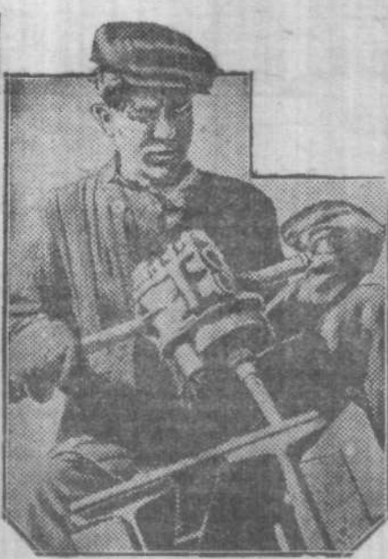
КУЗНЕЦКОСТРОЙ. Пневматическая сверловка дыр в сборе конструкций моста нового цеха.
