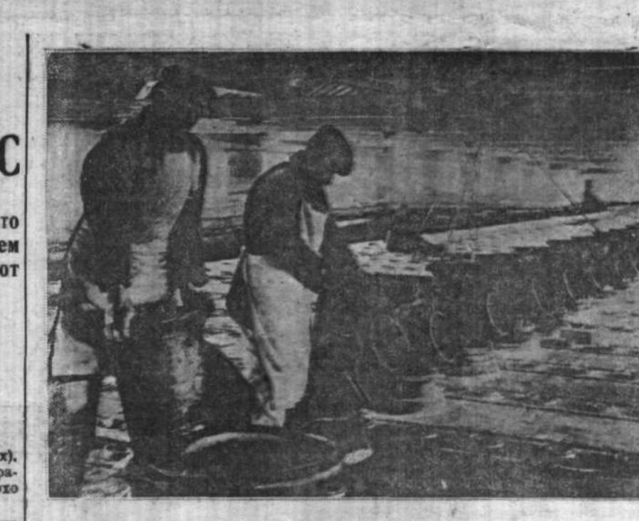
На снимке: работы на постройке 3-ей коксовой батареи в Кемерове.
