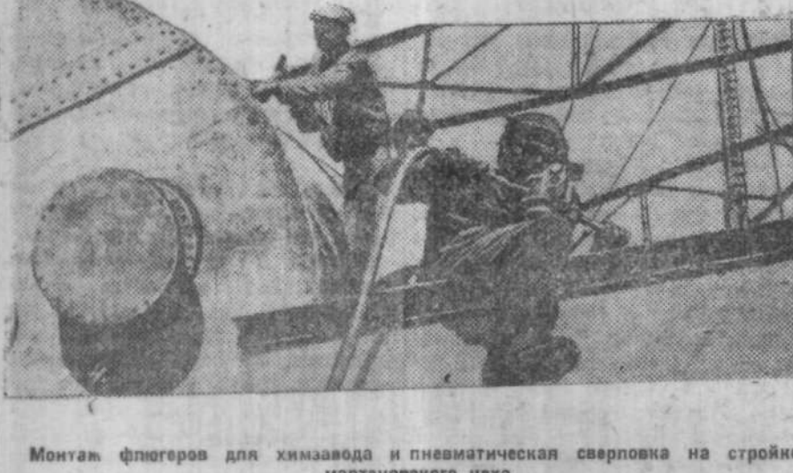
Монтаж флюгеров для химзащиты и пневматическая сверловка на стройке мартеновского цеха.
