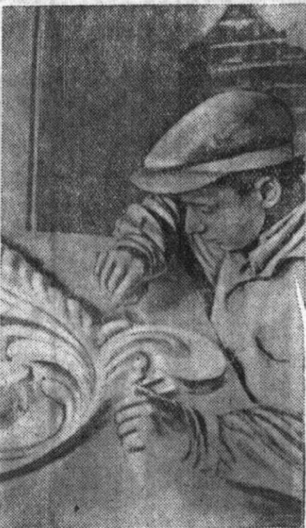
На строительстве новосибирского оперного театра. На снимке: формовщик-консольщик Г. Коротаев готовит формуку части плафона.
