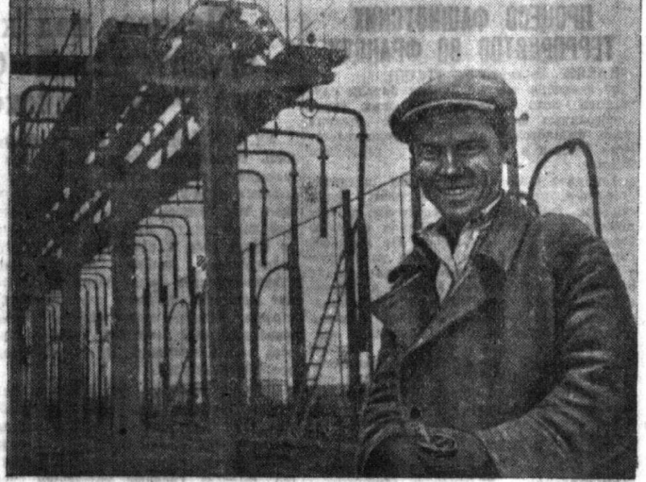
В г. Уфе (Башкирия) закончено строительство большого нефтеперерабатывающего предприятия. На снимке: газопроводный станок Байдары Пахырбаев у сливной отстойки для наполнения цистерн, которую он монтировал.
