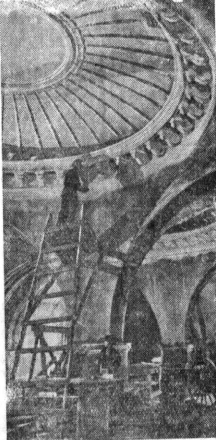
На строительстве Ленинградского радиуса Московского метрополитена второй очереди. На снимке: работы по отделке станции метро «Соколь».
