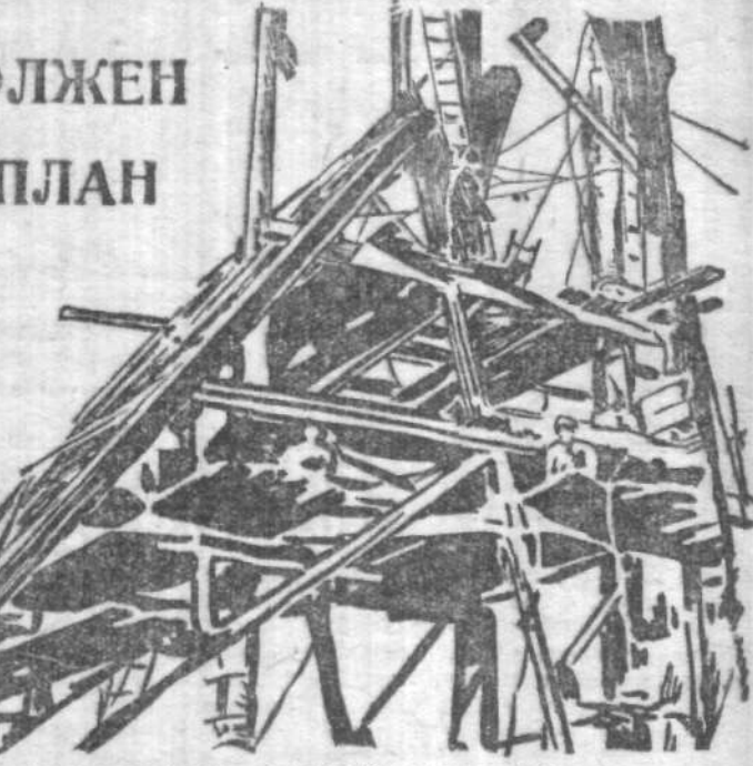
Анжер. Монтаж железного копра, строящейся шахты 15-й.
