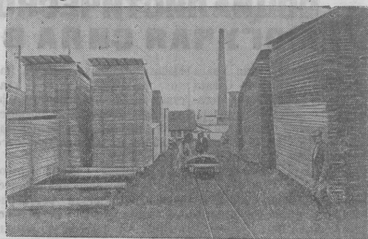
Склад пиломатериала Краснопольского фанерно-лесопильного завода (Северная Буковина)
